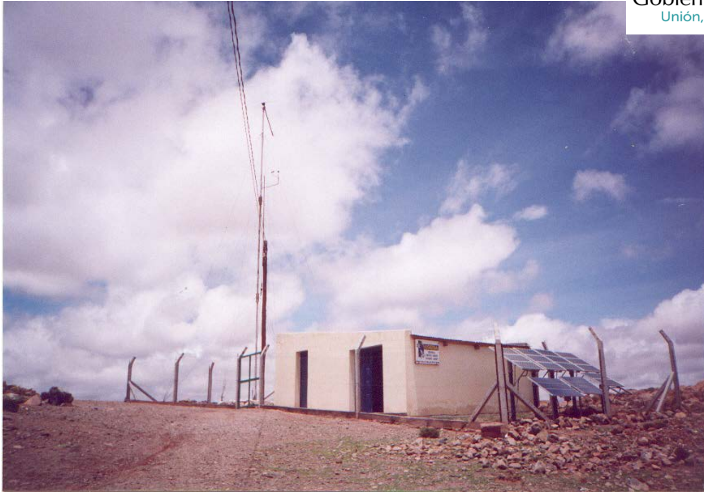
Sistema Híbrido Solar-Térmico-Eólico de la localidad de Pastos Chicos, 33 Usuarios 17 kVA / 1450 Wp / 600 W Dpto. Susques
