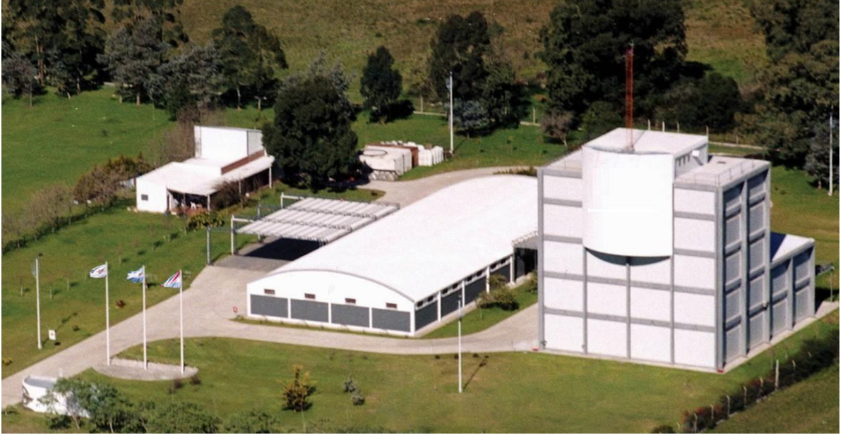
Planta de producción de carbonato de sodio de QUIMSUR (Lobos; Provincia de Buenos Aires).
