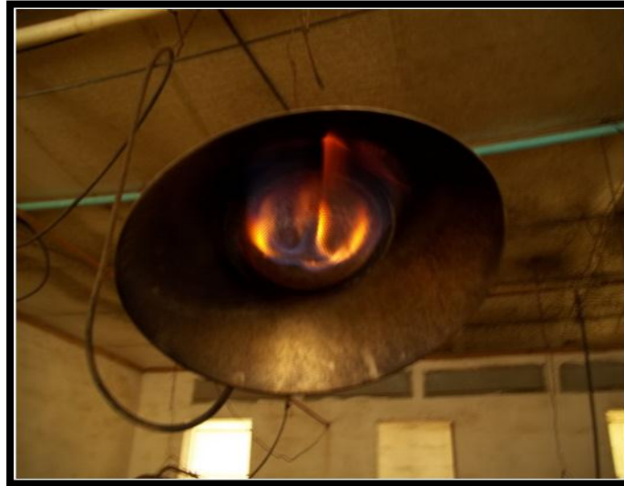
Figura 31: calefacción de galpones con biogás
