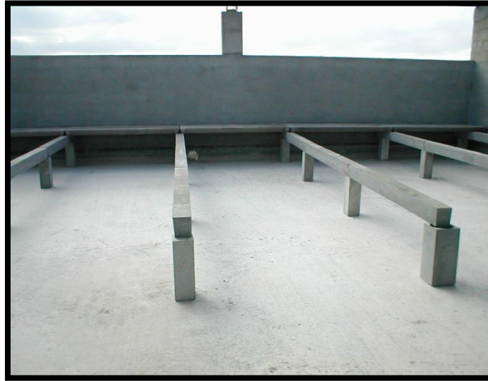
Figura 17: disposición de las vigas y pilares
