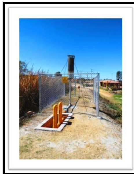
Figura 36: antorcha de seguridad
