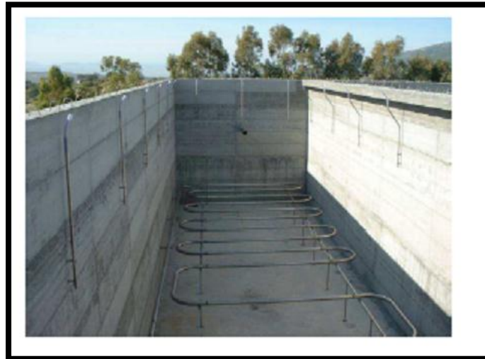
Figura 25: intercambiadores de calor
