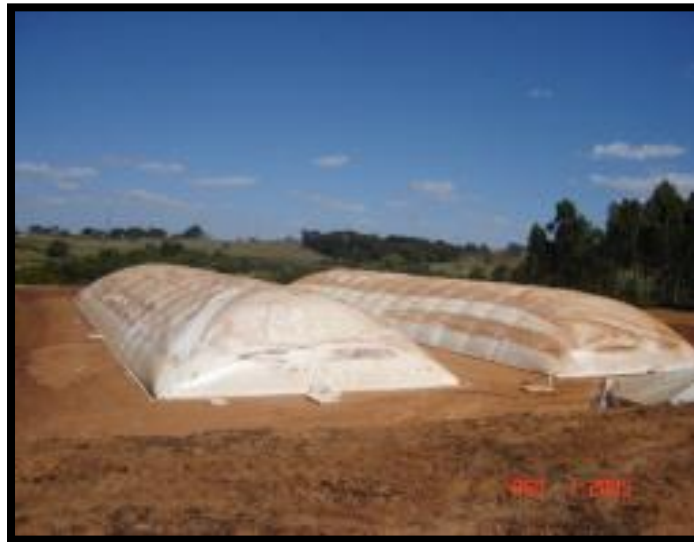
Figura 24: biodigestores tipo canal
