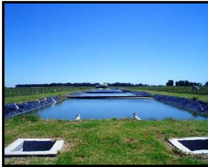
Figura 37: lagunas aeróbicas
