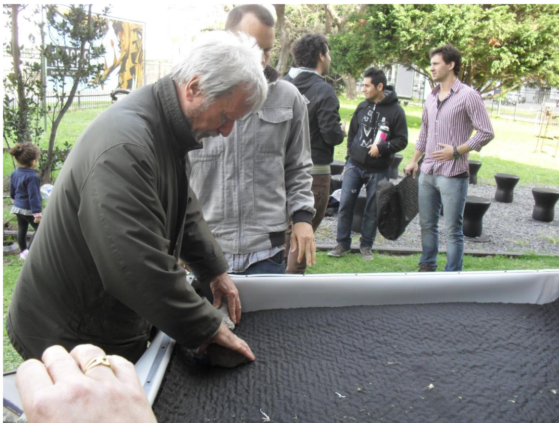
Figura 25: membrana geotextil ya colocada, se disponen las piedras.
