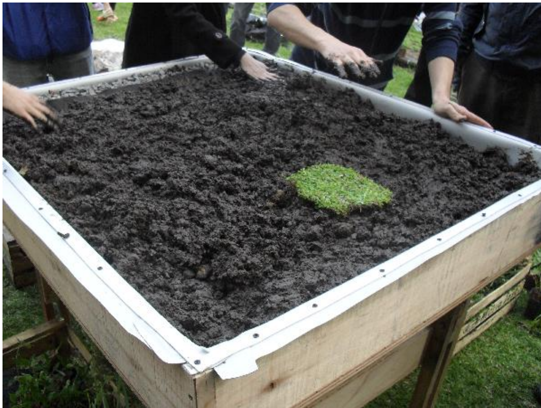
Figura 28: llenado del módulo o techo
