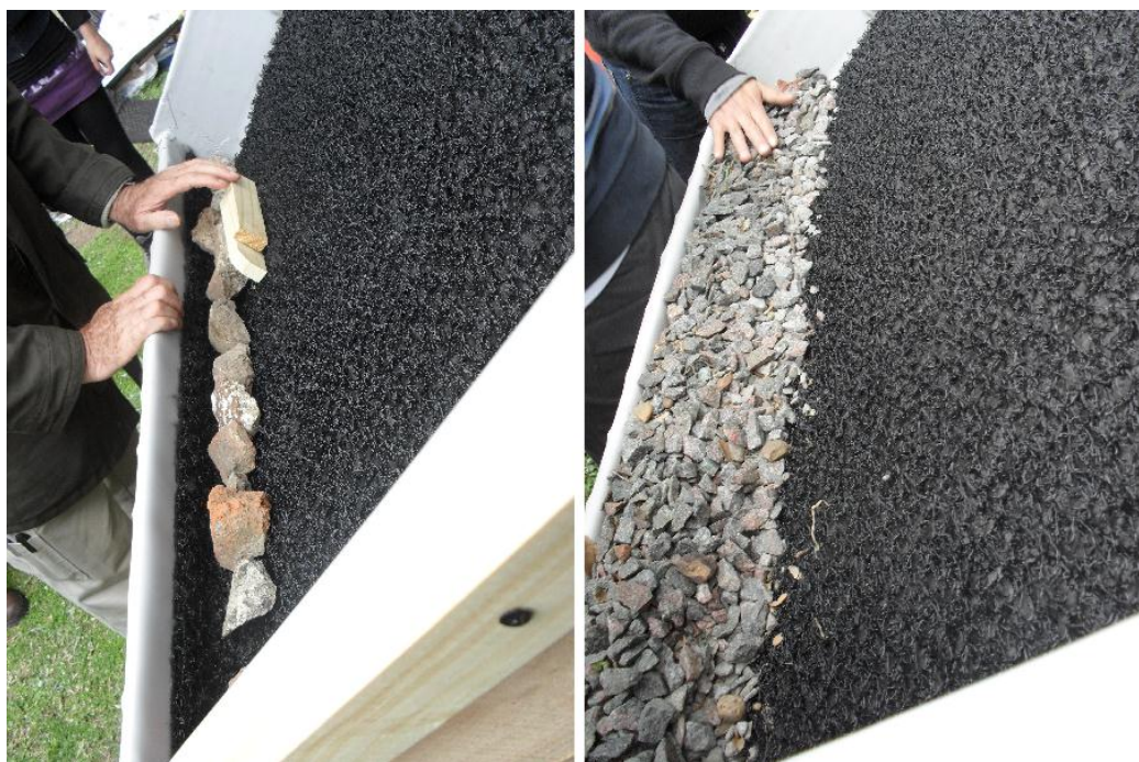
Figura 31: detalle de terminado del borde, colocación de piedras
