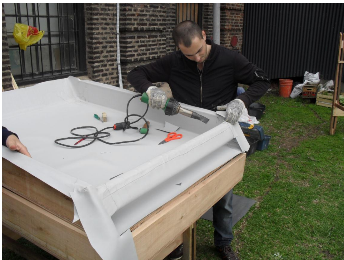
Figura 18: aplicación de láminas de PVC sobre el techo modelo
