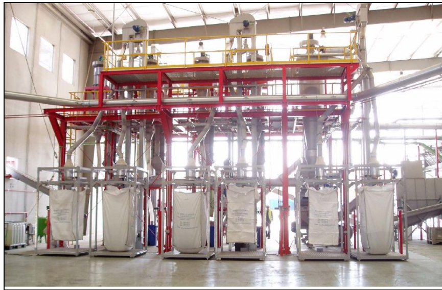
Figura 15: Almacenamiento en BIG BAGS
