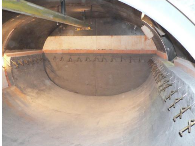
Horno con el proceso de gunitado - Hormigón refractario
