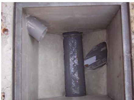
Figura 20: Arqueta vista superior
