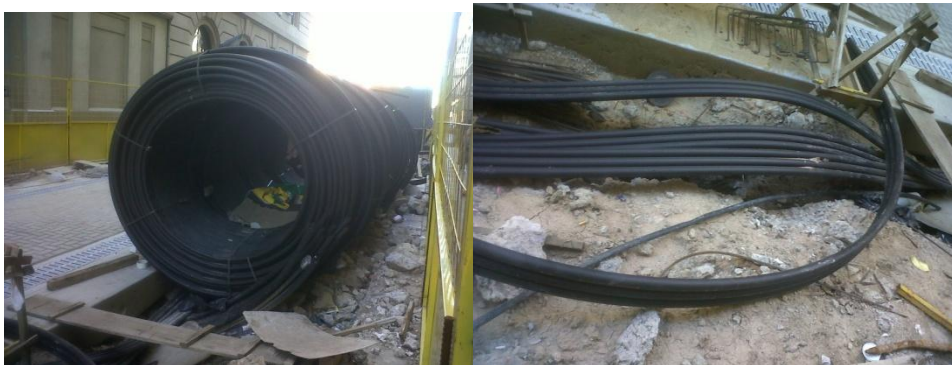
Figura 17: Tritubos en la obra civil.
