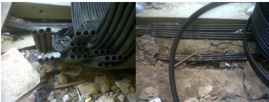
Figura 18: Rellenado y compactación.
