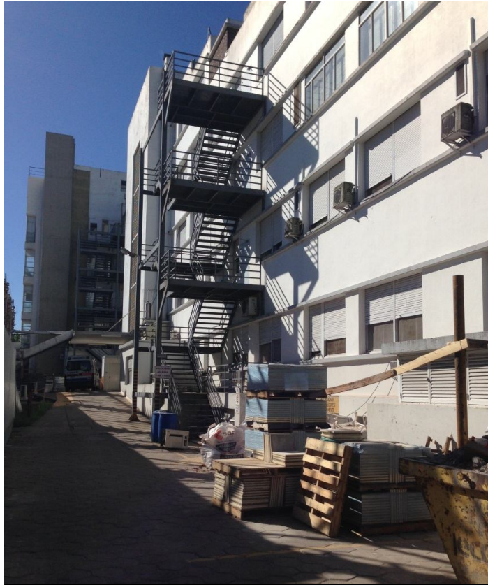
Escalera de emergencia ubicada en uno de los laterales del hospital
