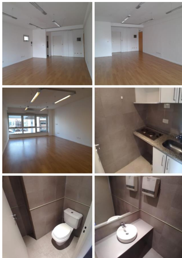
Fotos del interior de la oficina
