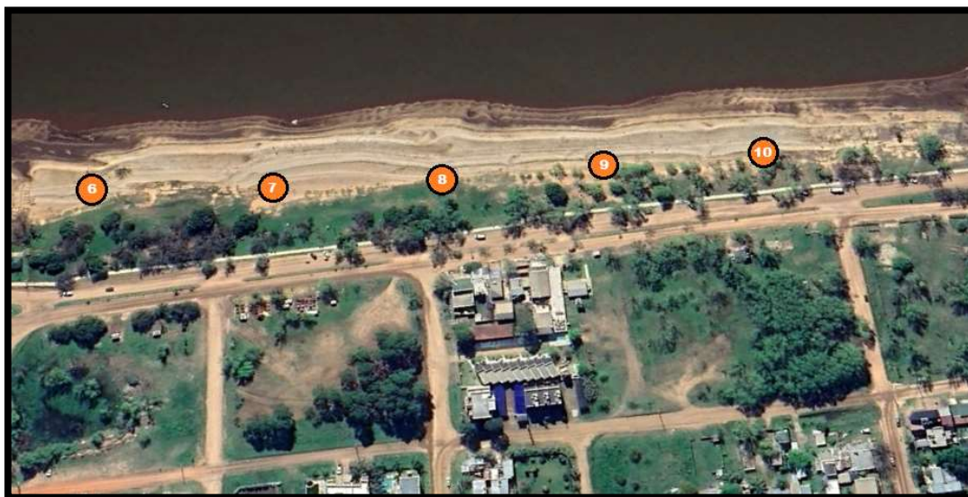
Figura N° 41 Ubicación de las columnas de iluminación en el balneario norte
