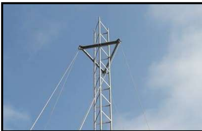
Figura N° 29 Estrella estabilizadora anti-torsión
