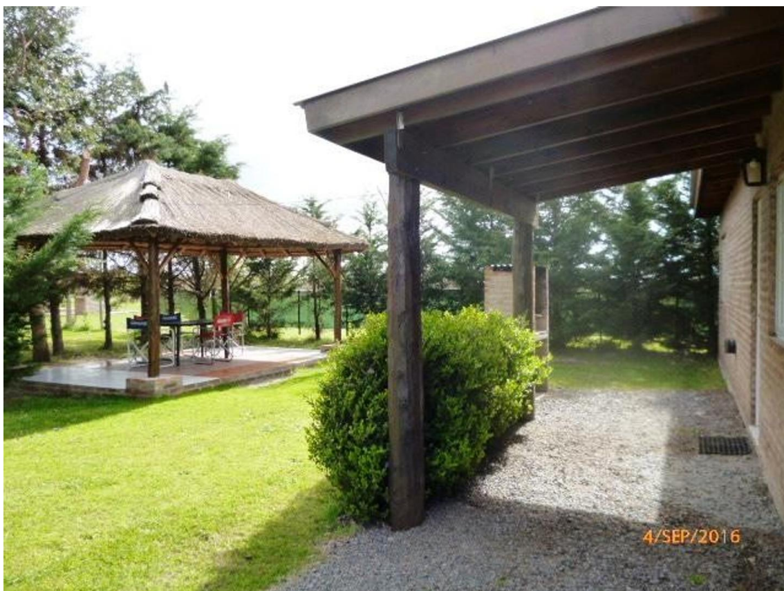
Ilustración 49: Costado lateral (Fuente: Apart de la Laguna, Imágenes Google Maps)
