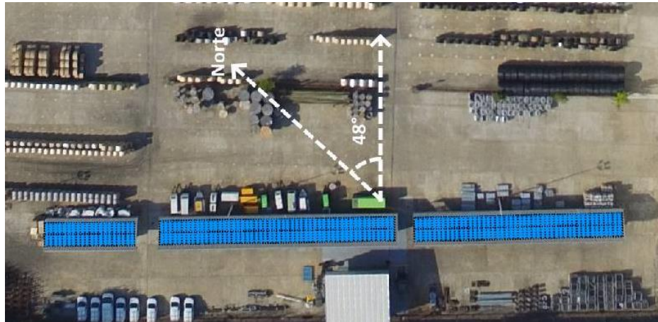
Figura 32: Representación de la disposición de los paneles solares.
