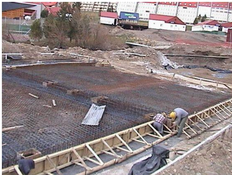
Figura 112: Construcción de Platea
