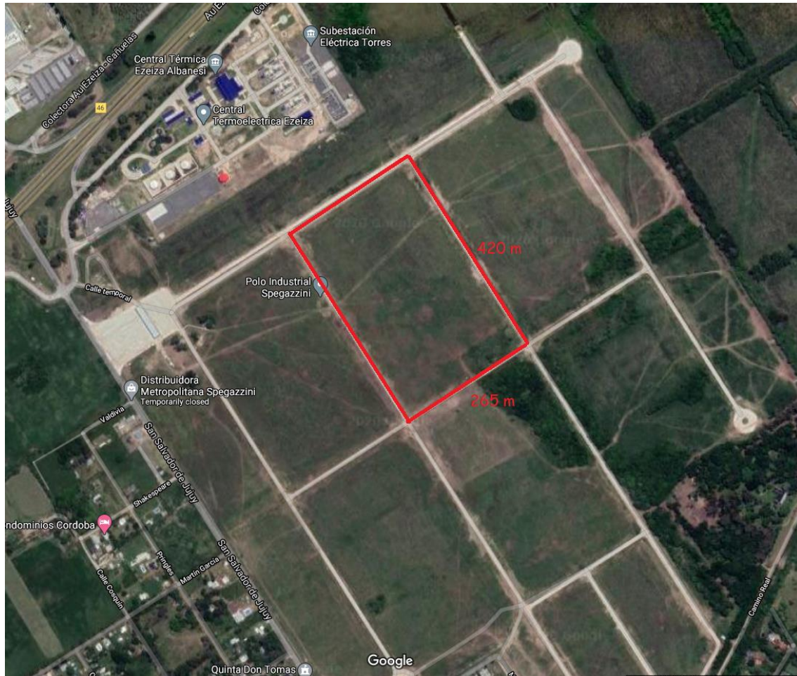
Figura 18: Vista superior del predio donde estará ubicado el Polo Industrial Spegazzini
