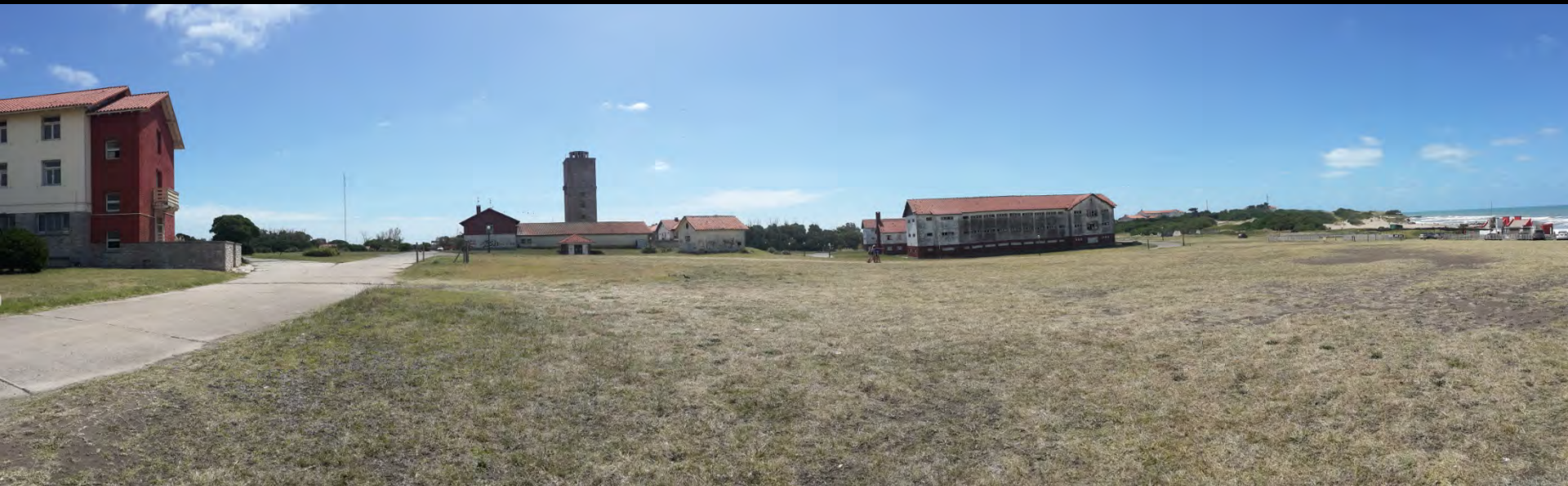
PABELLÓN DE SERVICIOS CON TORRE DE AGUA, HOTEL INFANTIL 3 (DER) Y HOTEL 4 (IZQ) FUENTE: Archivo personal
