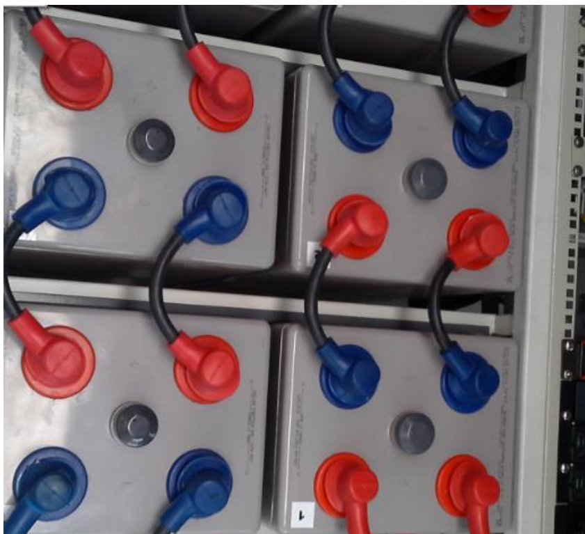
Figura 56: Inspección realizada por los alumnos.
