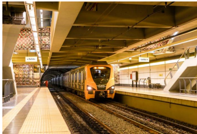
Figura 13: Iluminación LED en la estación Córdoba de la línea H de subterráneos 9
