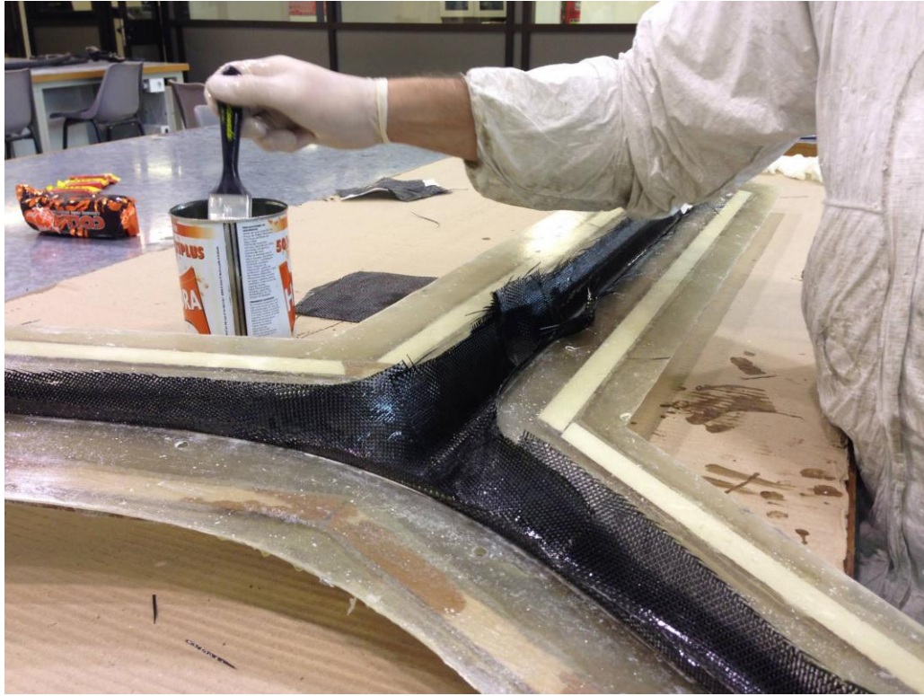
Reforzado con nuevas capas.
