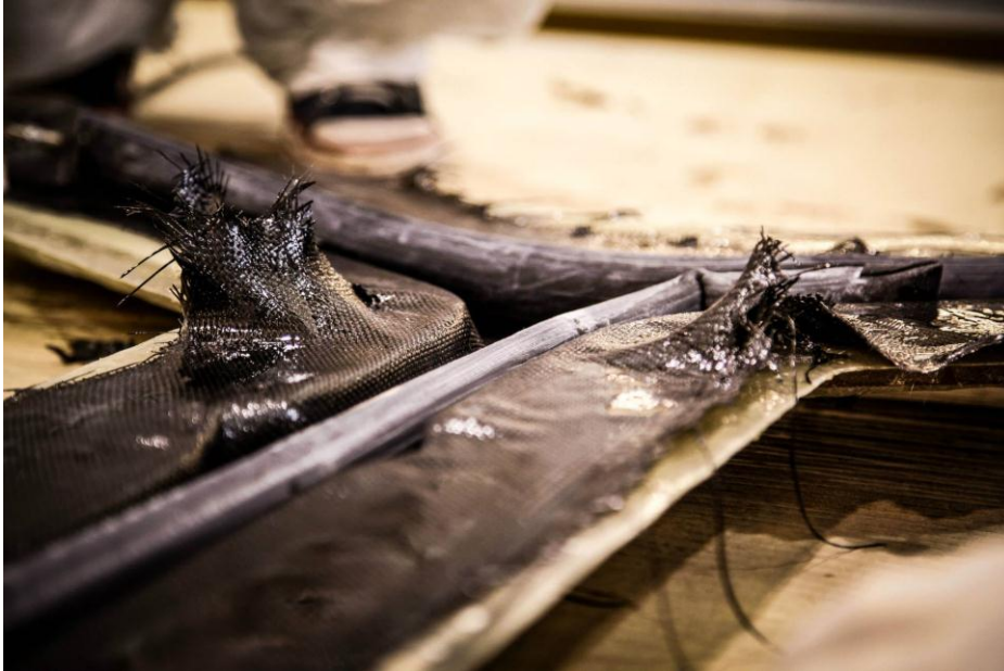
Colocación de las vejigas en el molde.
