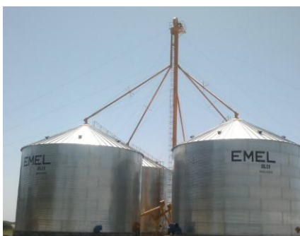
Fig39. Silos con noria de carga.
