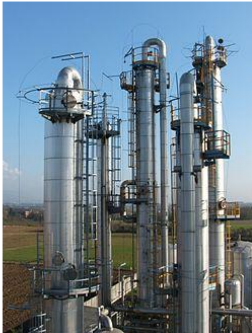
Fig. 31 Vista exterior de torres de destilación
