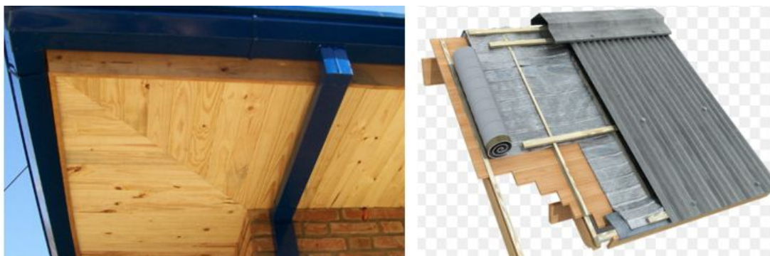
FIGURA 75: Techo interior y aislante térmico del edificio administrativo BAM SA.
