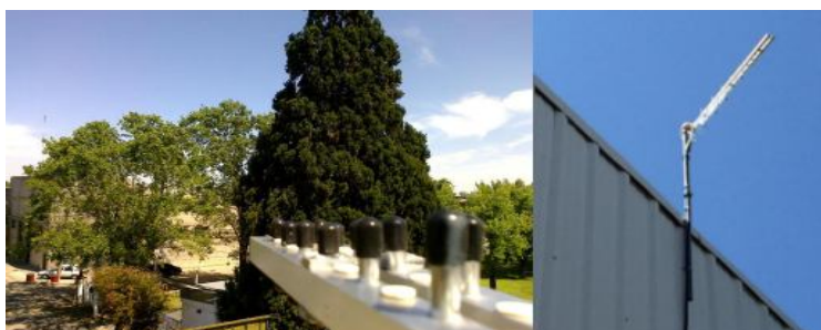
FIGURA 86: Línea de vista de antena donora (VRS024) y antena captora de señal.
