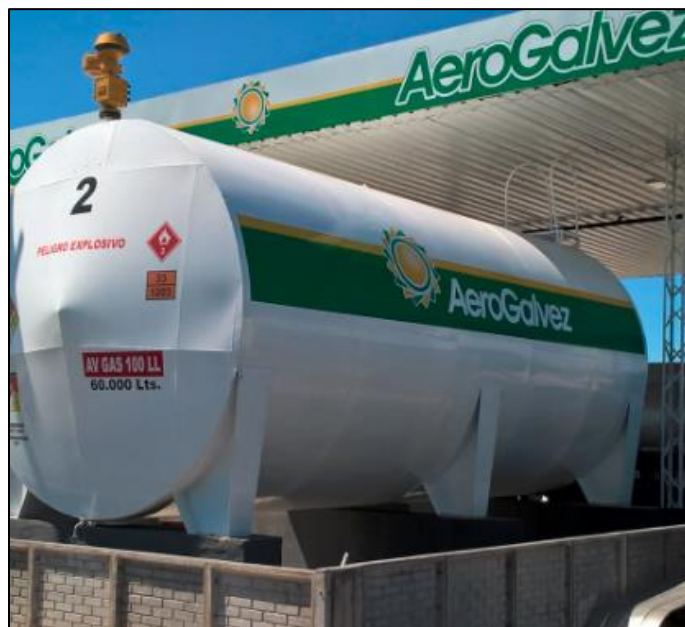
Figura 15: Instalación de tanques de almacenamiento.
