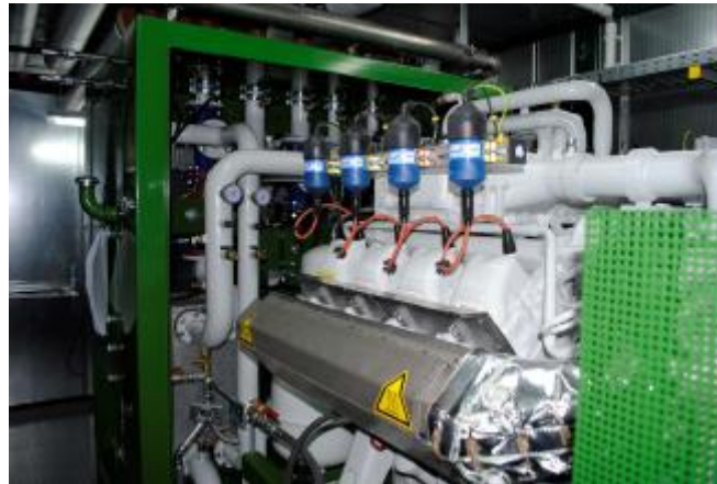
Imagen VII: Motor co-generador (adaptado al funcionamiento con biogás)
