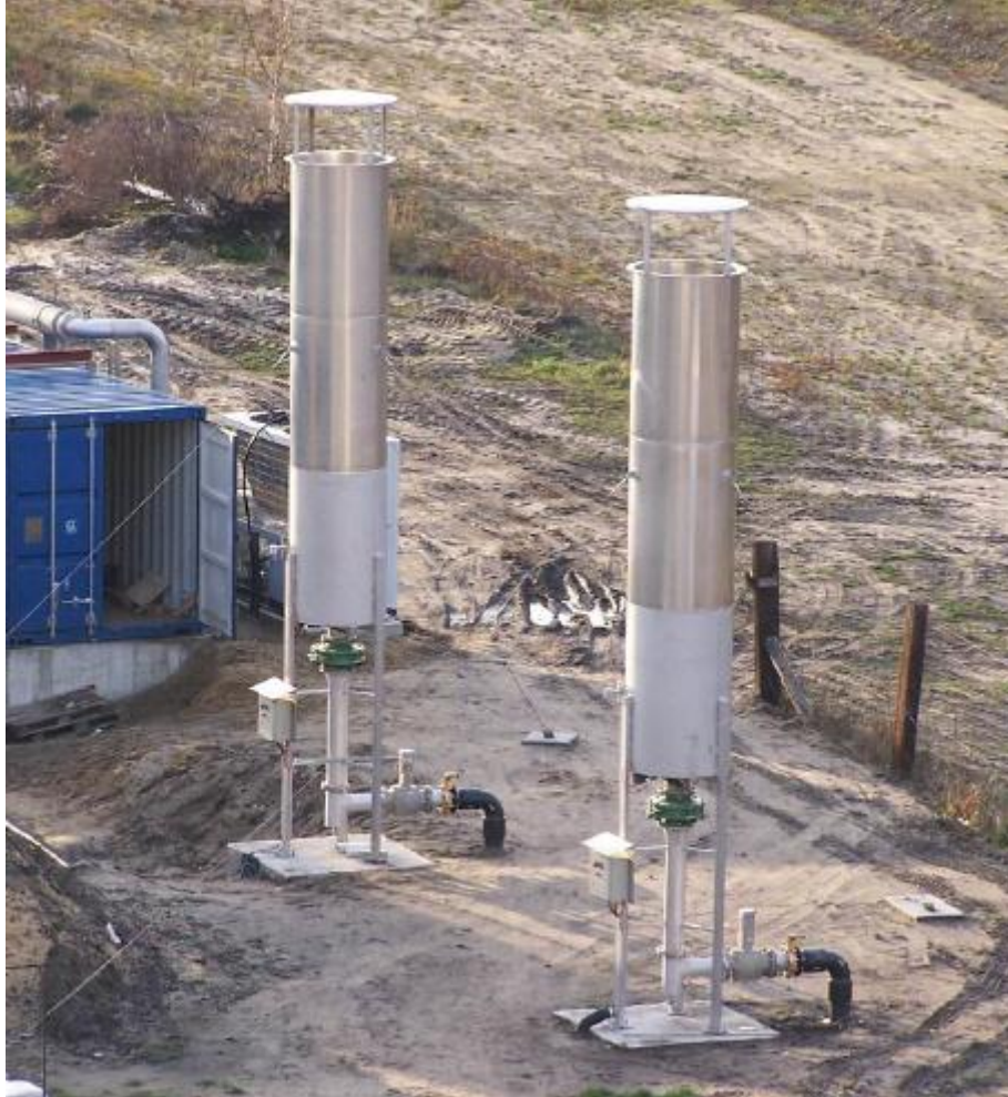
Imagen III: Antorchas para quemado de biogás
