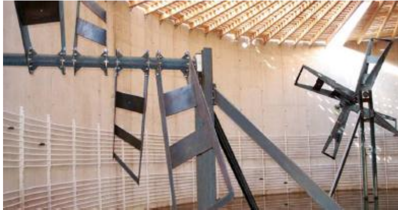
Imagen V: Post digestor, agitador de 15 hp – homogenizado de biofertilizante
