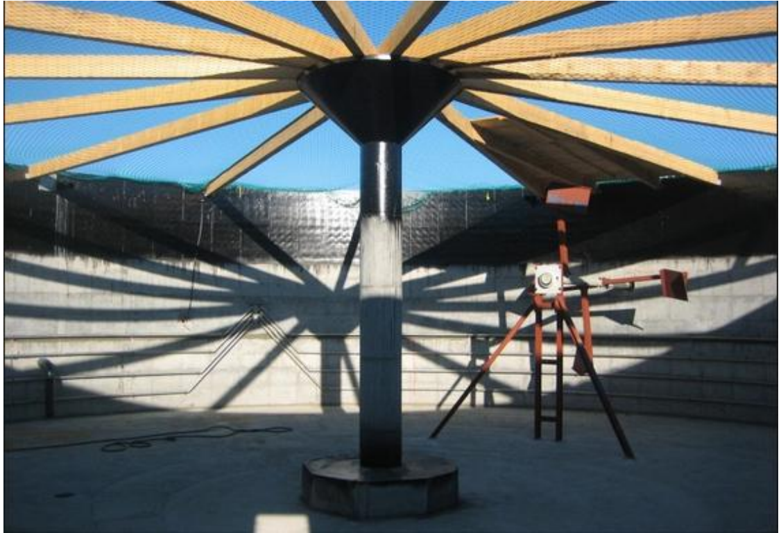
Imagen I: Biodigestor en construcción
