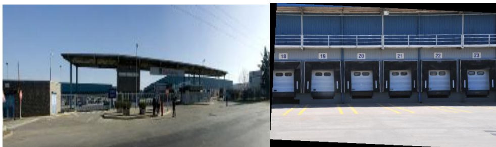
Figura 16 - Ingreso con vigilancia compartida y docks con dockleverers hidráulicos
