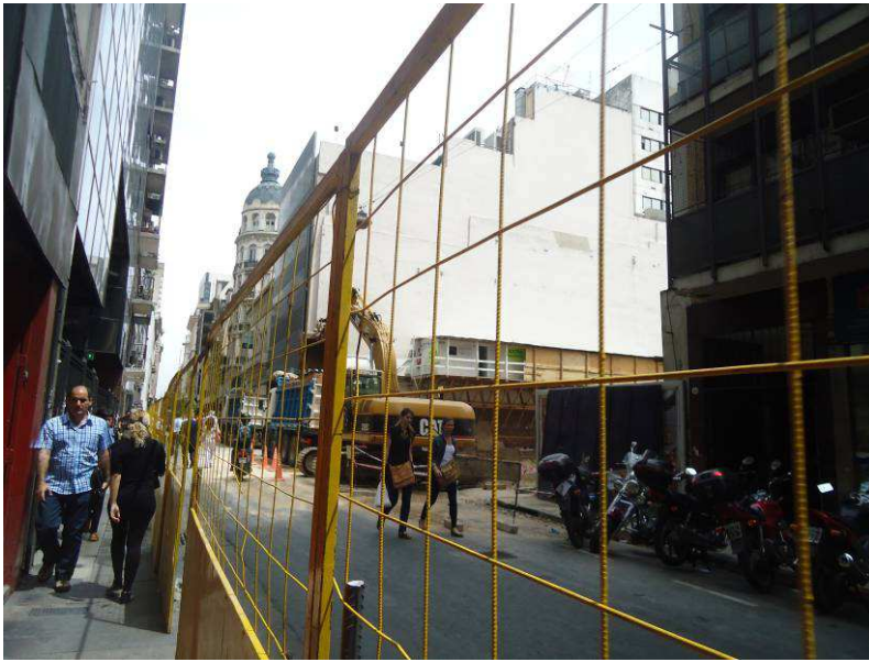
Figura 25: Peatonal en construcción.
