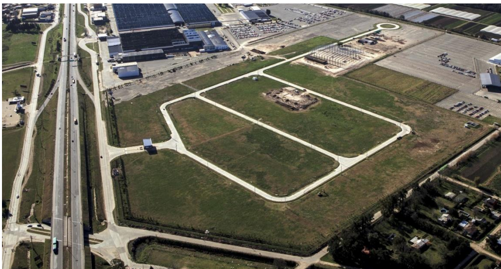
Figura 45: Vista aérea parque industrial de Berazategui.
