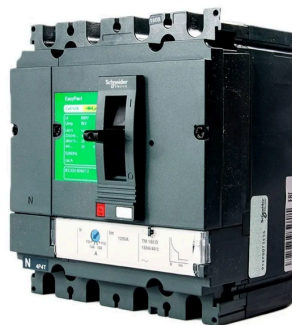
Figura 98: Interruptor termomagnético entrada y máquinas
