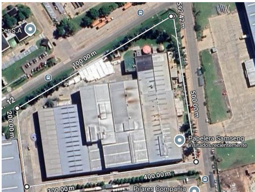
Ilustración 3 - Vista satelital de las instalaciones de Papelera SA (sup. Aproximada 20.000 m 2 ).
