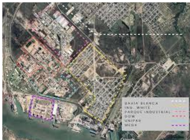
Figura 10: Polo Petroquímico de Bahía Blanca (Marquinez, 2025)
