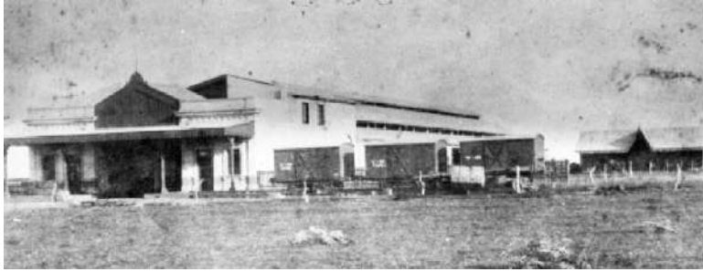
Antigua estación del Tramway Rural, actual estación Federico Lacroze. Año 1899.
