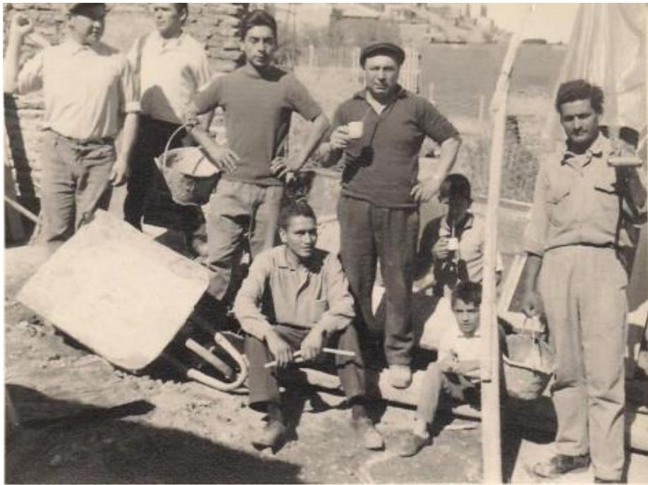
Figura n°1.2: Construcción del templo de la Iglesia Pentecostal, por Luciana Lago, 2018
