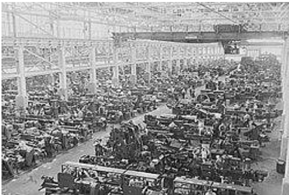
Interior de la fábrica Detroit-Rive Rouge en 1944
