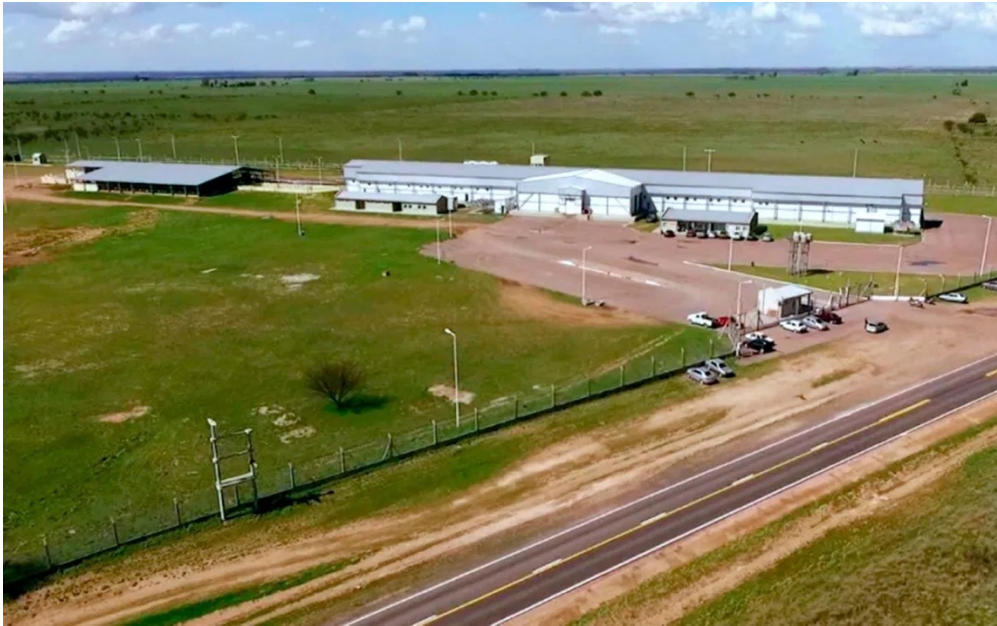
Planta Bernasconi. Fuente: El Diario de La Pampa. Recuperado de: https://www.eldiariodelapampa.com.ar/locales/410-la-provincia-vendio-el-frigorifico-de-bernasconi-en-mas-de-400-millones-de-pesos
