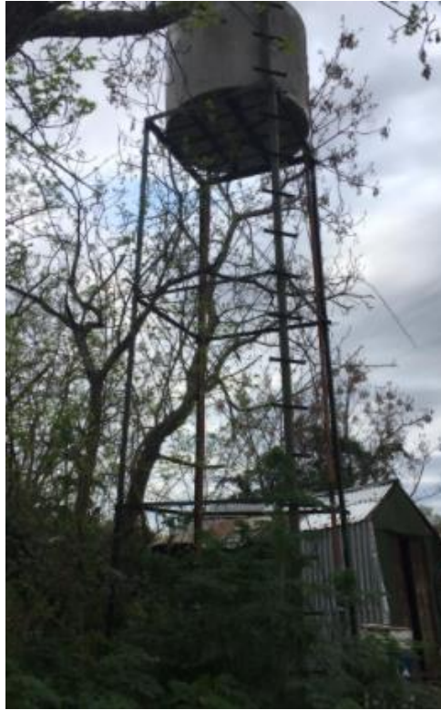
Figura 38: Instalación de agua instalada en el terreno
