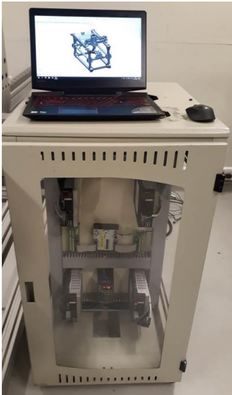
Fig. 18: Gabinete de control
