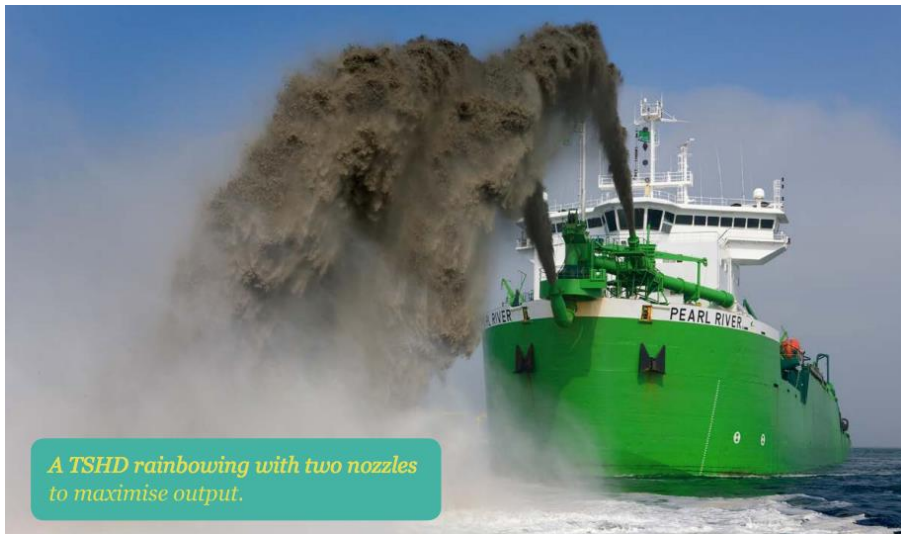
Ilustración 21: TSHD descargando material mediante "rainbowing" para un relleno hidráulico
