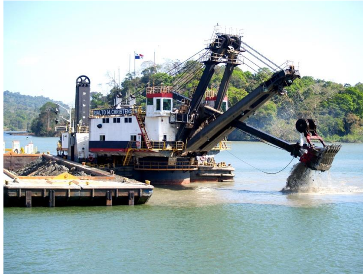
Ilustración 15: Draga de pala frontal en operación
